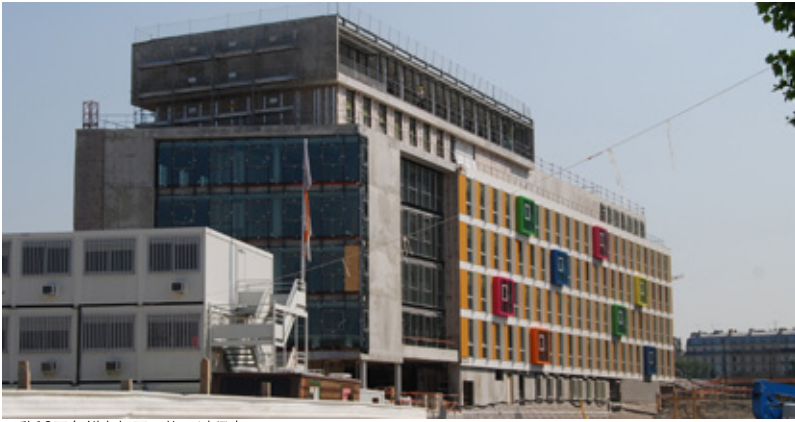
巴黎18区鱼鲜市场区·施工过程中
