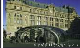
全自动化14号线地铁站入口
