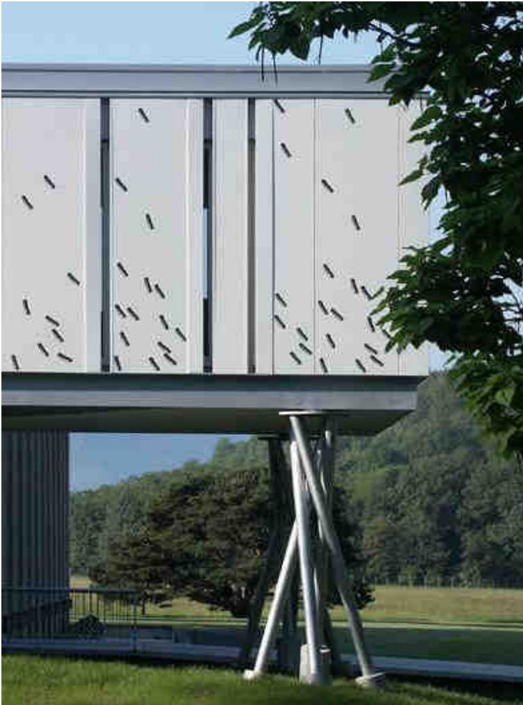
STATION DES EAUX - GRENOBLE
